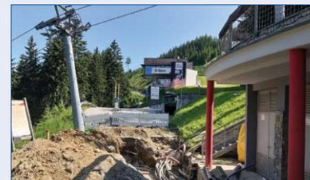
Eine Beschneiungsanlage braucht viel Strom, Strom den die Stadtwerke Schwaz nachhaltig und ökologisch aus Wasserkraft produzieren. Für den Transport der Energie musste eine neue 10 kV-Übergabestation in unmittelbarer Nähe zur Liftstation Grafenast errichtet werden.
